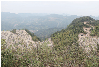
西溪镇尚黄桥村平整地工程
