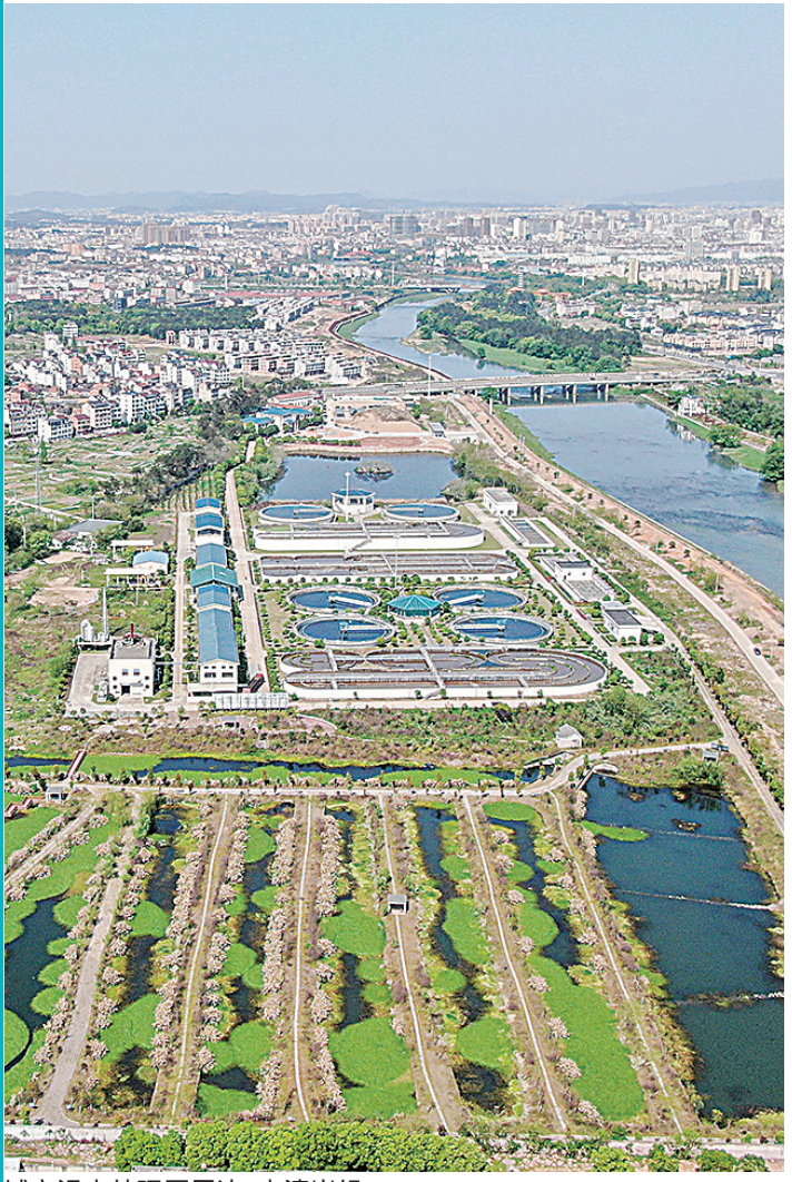
城市污水处理厂周边 水清岸绿。
