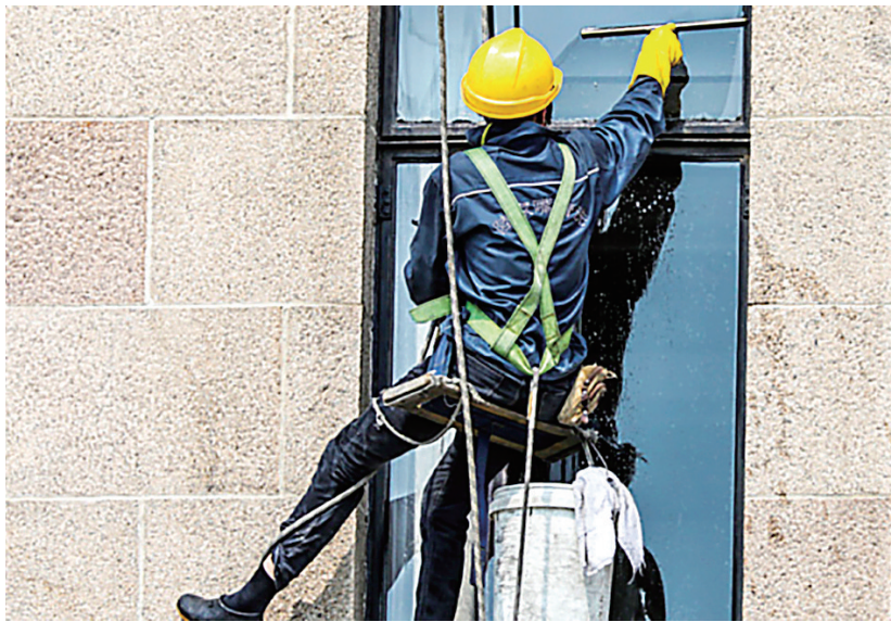
高处作业须做好安全防范措施
