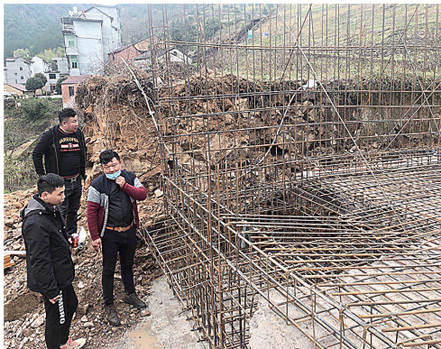
设计人员对里洋水厂施工现场进行指导
