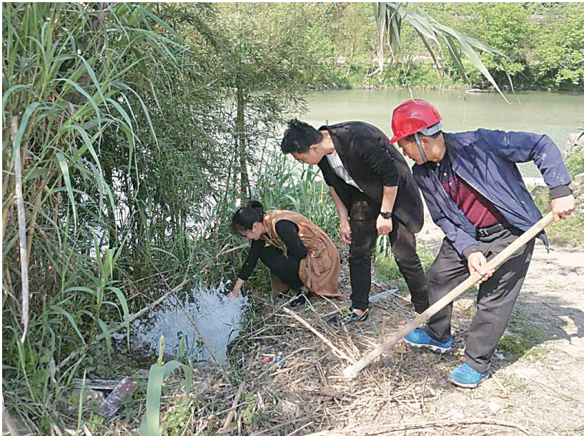
工作人员在管网冲洗现场作业。
