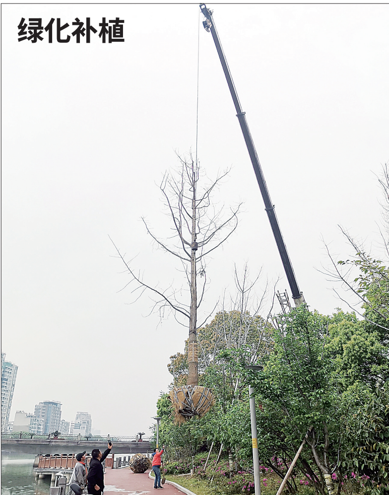
近日，园林部门对城区绿化带的死亡苗木进行全面清点，并根据植物的生长情况，制订了补植和养护计划。图为园林工人正在滨江绿化带补植绿化树木。
