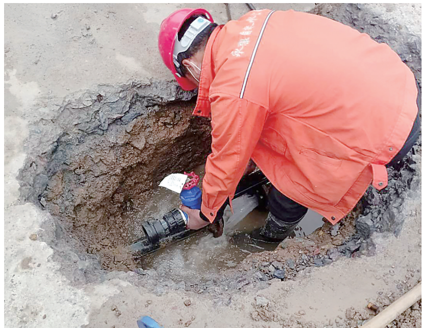
工作人员在现场维修
