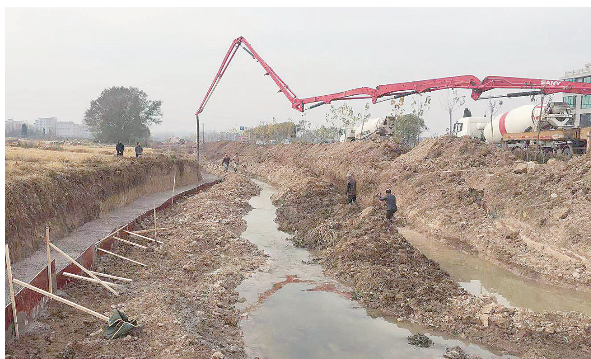
开发区车马何溪拓宽施工现场
