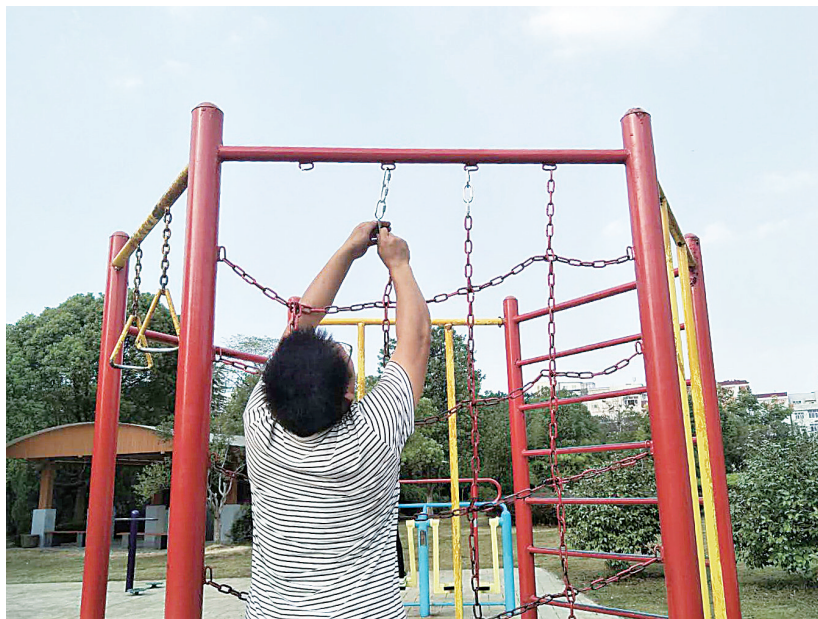
工作人员为健身器材更换部件
