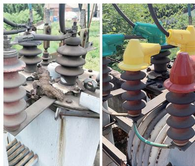
的金属桩头桩头,它们基本露天裸露。动物是良好的导体,这些爱爬配电台架的猫、老鼠、松鼠等小动物,一旦跳到用户产权电力变压器的三相电上,身体任意两个部位同时触碰ABC三相电中任意二相,就一定发生触电,最后导致变压器短路。
