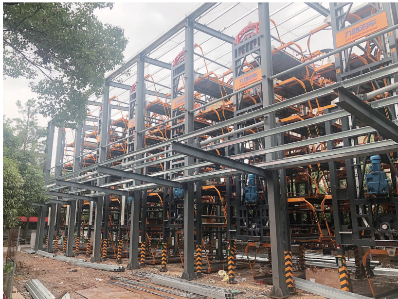
市妇幼保健院正在建造中的立体停车库
