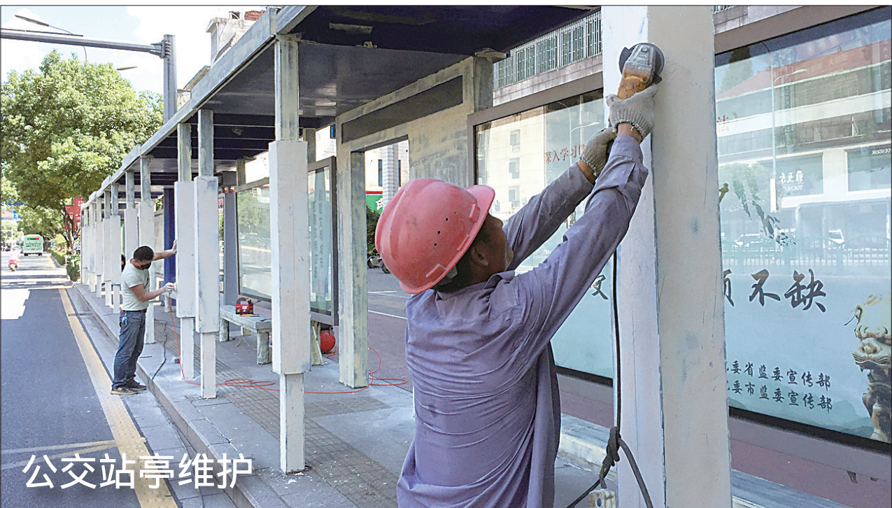
公交站亭维护 近日,运通公交公司对公交站亭进行了维修养护,以确保站亭整洁美观。 记者 林群心 摄
