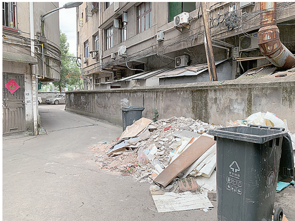
倾倒在通道上的建筑垃圾
