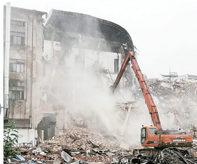
原鹏飞汽修厂拆除现场
