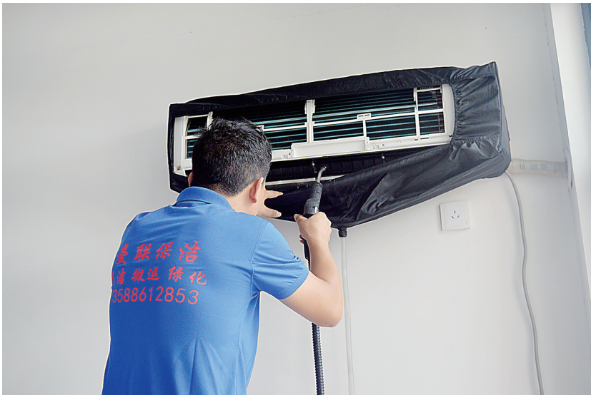
清洗空调(资料照片)
