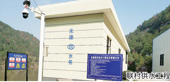
联村供水工程
