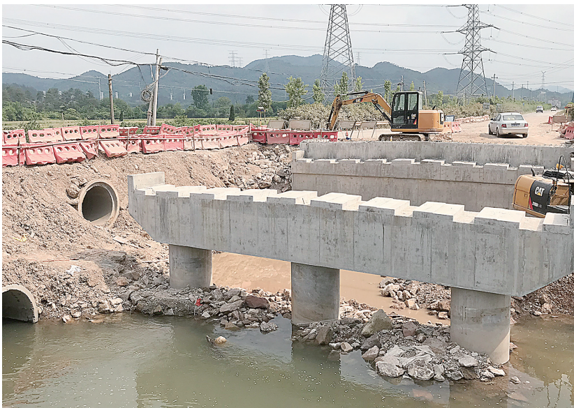
石桥施工现场。
