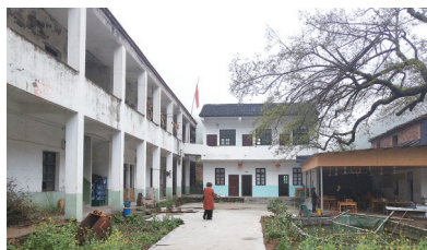
金坑中小学校舍现状
