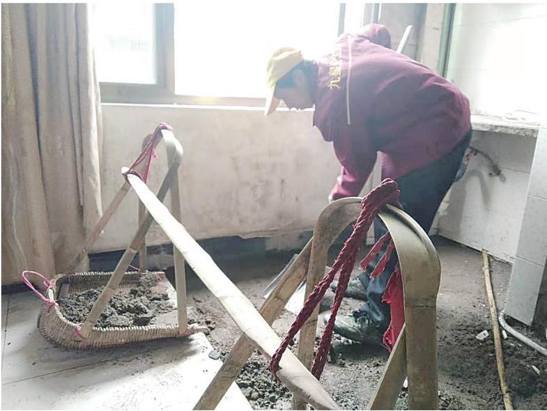
这根细水管是通往卫生间的,敲开这几块地砖,暂时没发现水管破裂的迹象。吕师傅推测,可能是水管破裂位置在还没敲开的地砖底下,也可能是洗手池下面的粗水管接头松动,造成漏水。
