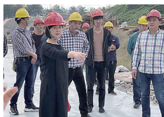
走进建筑工地督导污染防治
