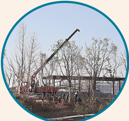
施工人员植树添绿
