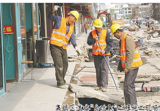
象珠镇清渭街环境综合整治施工现场
