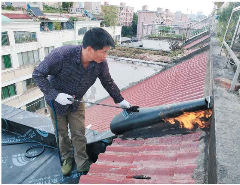
整个过程,我都在一边看着,时不时问一些关于防水的问题,师傅都很耐心地解答。应先生说,在这个过程中,他表示要对阳台外侧的墙壁进行粉刷,应师傅则建议,最好等到防水材料铺设完毕、下过一场雨以后,确定不再漏水,再进行粉刷。
