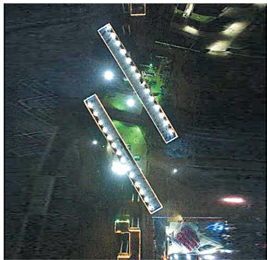
26日凌晨3点28分,汕昆高速公路龙川至怀集段英红特大桥上,全国首例超大吨位双幅高速公路桥梁成功转身,横跨京广高铁。桥梁采用290米分幅T构同步转体桥梁结构,转体梁体长度150米,相当于50层楼高,桥面宽度31.7米,相当于10层楼高度,单幅转体重量达13500吨,与一艘轻型航母重量相当。采用平行京广高铁线外挂篮悬臂现浇,两侧同步转体施工,转动角度左幅77.78°,右幅78.24°,按顺时针方向进行旋转。桥梁梁体从最初的分布在高铁两侧基本平行,转体完成后变成十字相交。
