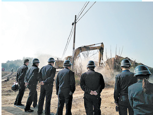
王力安防区块的队屋拆除现场
