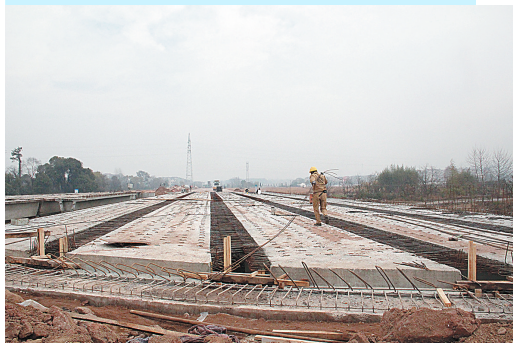
芝英连接线华溪大桥工程现场
