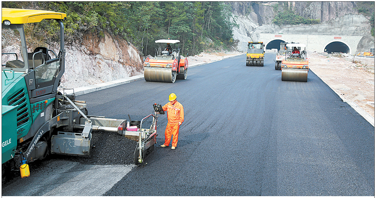
永义公路铺沥青 4日永义公路(木渠至童宅段)开始铺沥青。据悉 ,永义公路(木渠至童宅段)全长3.512公里 ,计划本月20日前完工。 记者 林群心 通讯员 卢鑫军 摄
