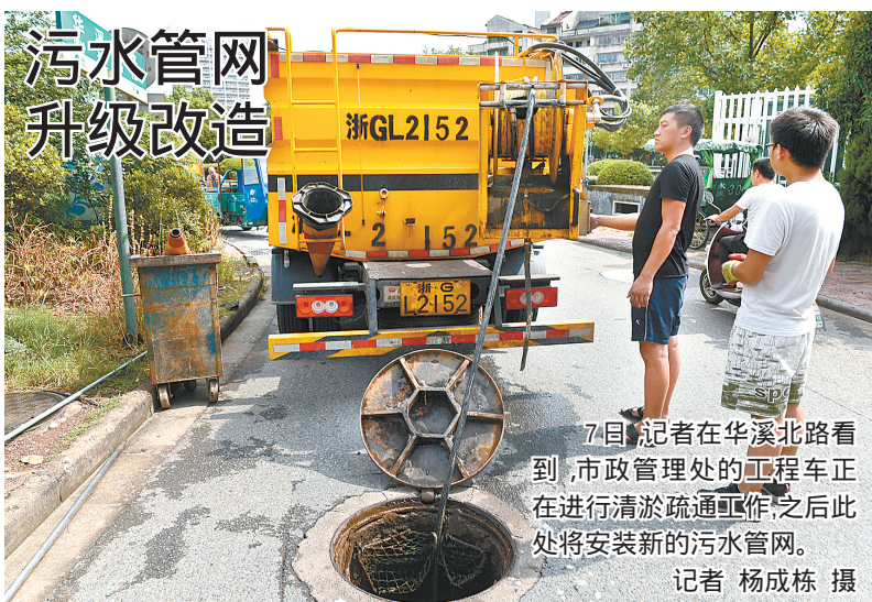
7日,记者在华溪北路看到,市政管理处的工程车正在进行清淤疏通工作,之后此处将安装新的污水管网。 记者 杨成栋 摄
