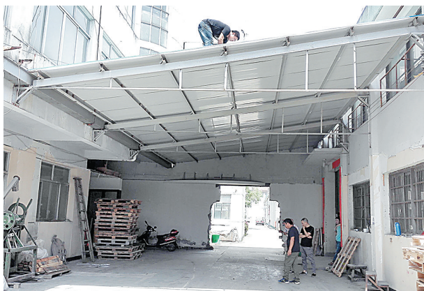
象珠工业功能分区内,企业主动派人在钢棚上对排查出的安全隐患进行整改。
