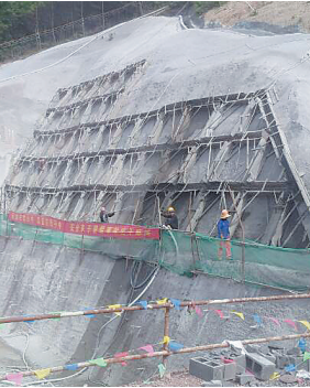
隧道仰坡框格梁施工
