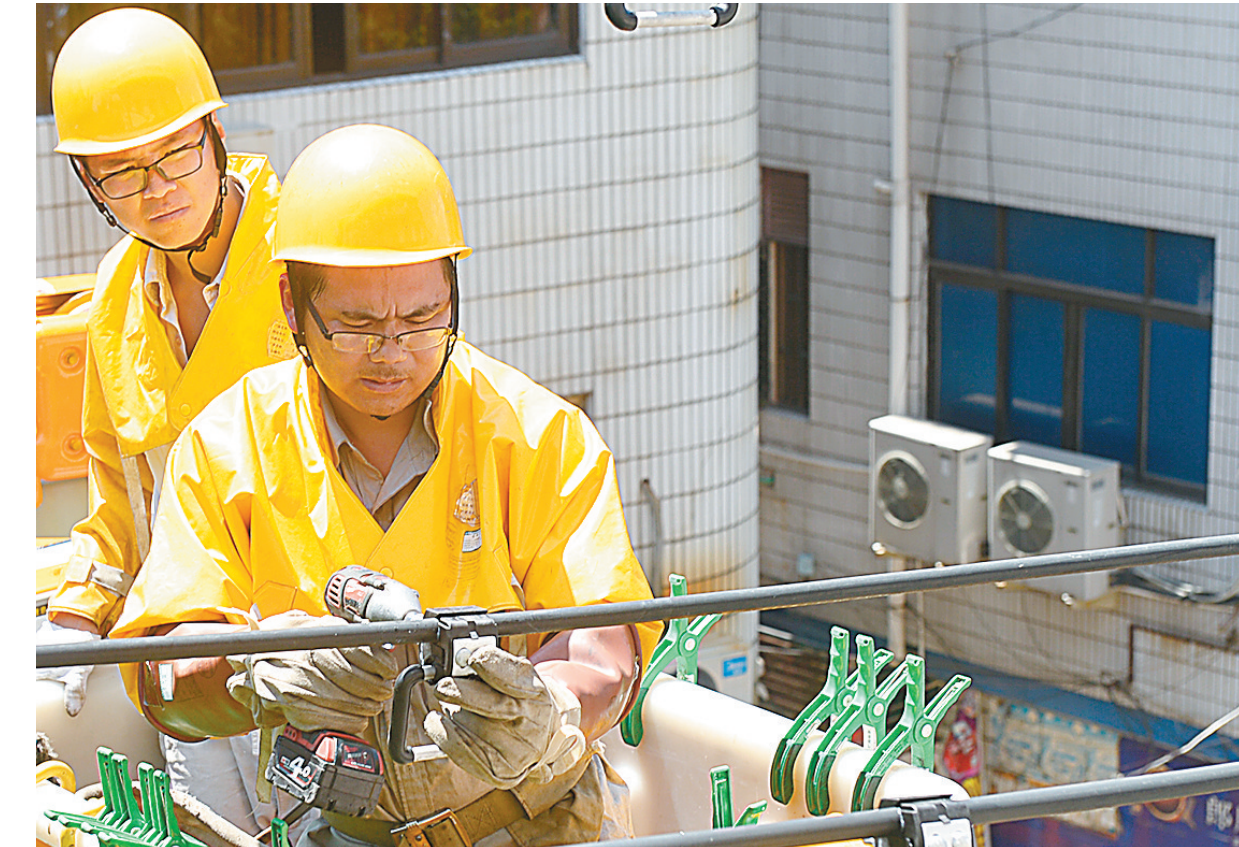
图为安装现场。记者 杨成栋 摄
