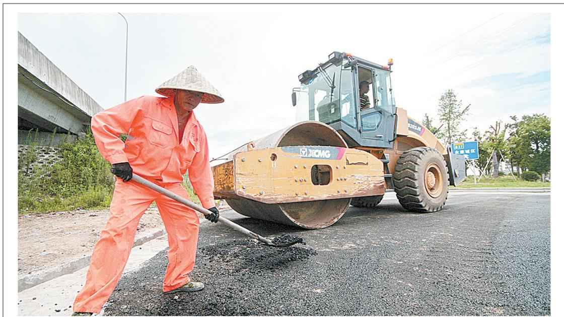
近日,市公路管理部门为确保洪灾过后的道路安全畅通,放弃双休日,对农村公路的沥青路面坑洞和塌方挡墙,进行抢修施工。图为石凹线水毁路段抢修场景。 通讯员 林加强 徐锦清 摄
