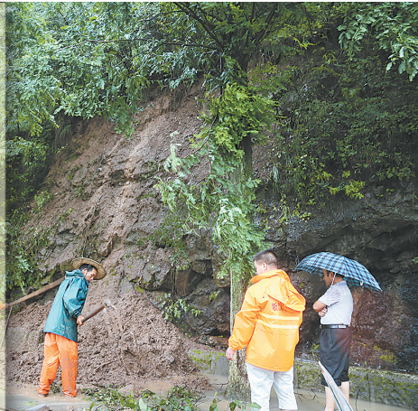
路政工作人员在山地滑坡现场清理落石和泥土。(本报资料图片)
