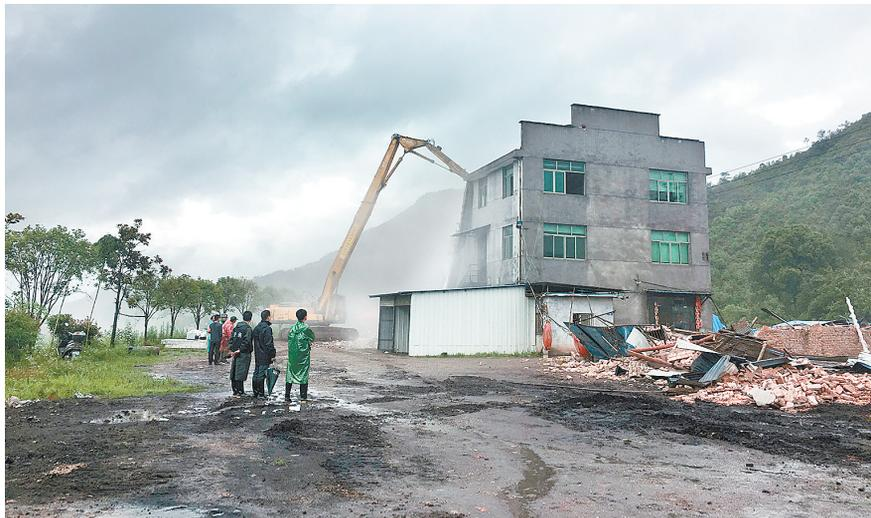
长臂挖机正在九里口村拆除三层半的厂房。
