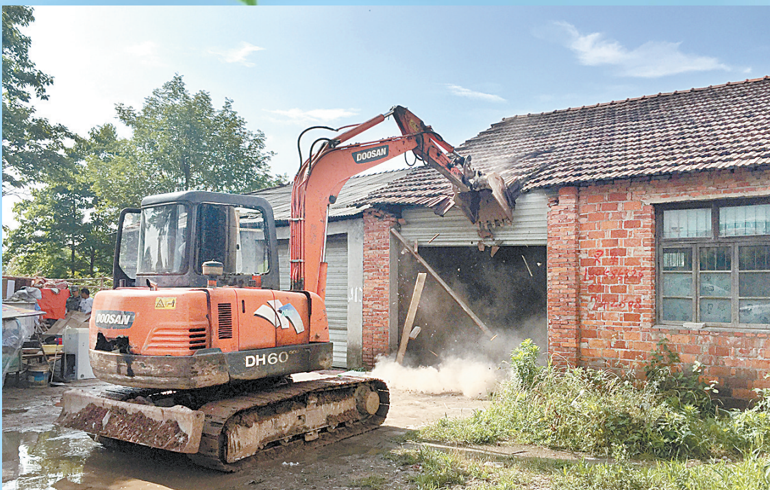
河南二村拆违现场
