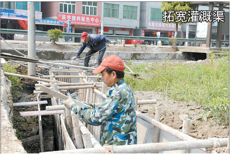
12日,记者在象珠镇山西村看到,几名工作人员正在对村口的灌溉渠进行修补和拓宽。据介绍,修补拓宽的渠道有850米,预计一个月内完成。 记者 杨成栋 摄
