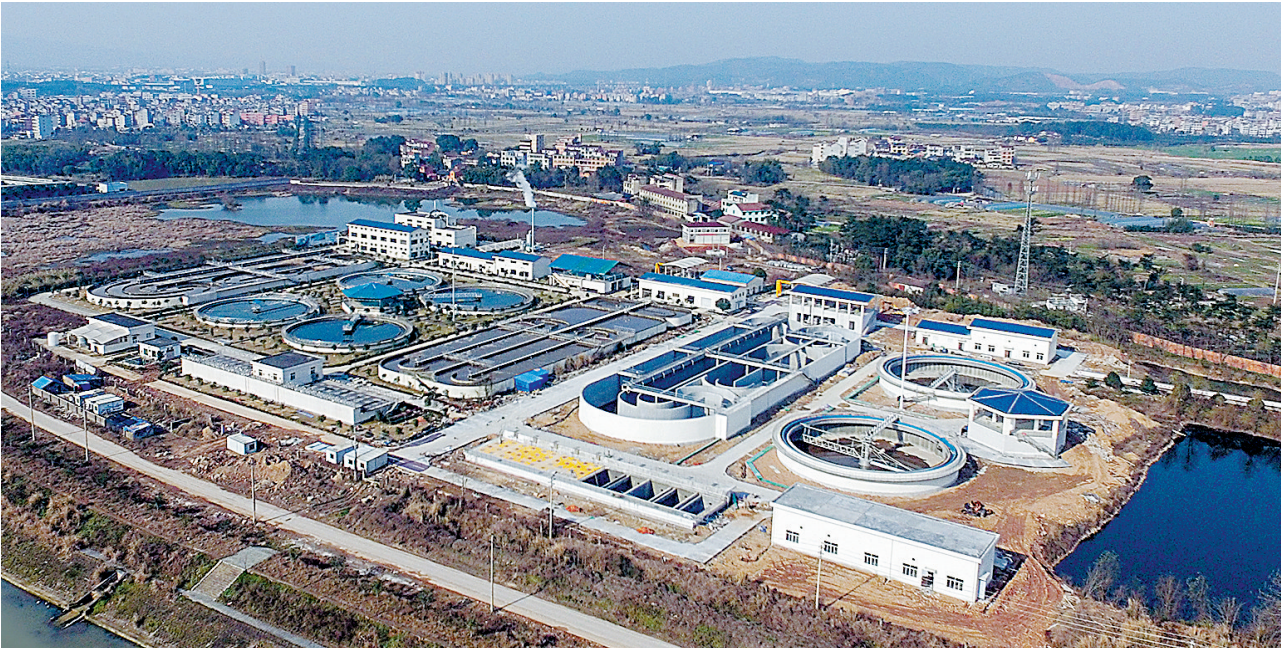
城市污水处理厂三期工程近日投入使用。据悉,城市污水处理厂总占地24万平方米,分四期实施。 记者 林群心 摄
