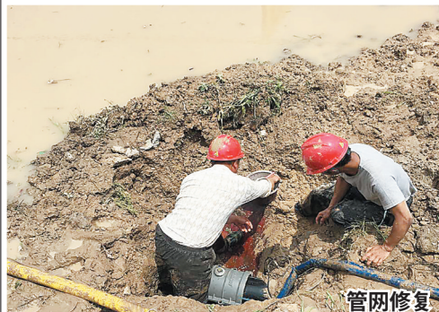
洪塘坑水厂钢管改线
