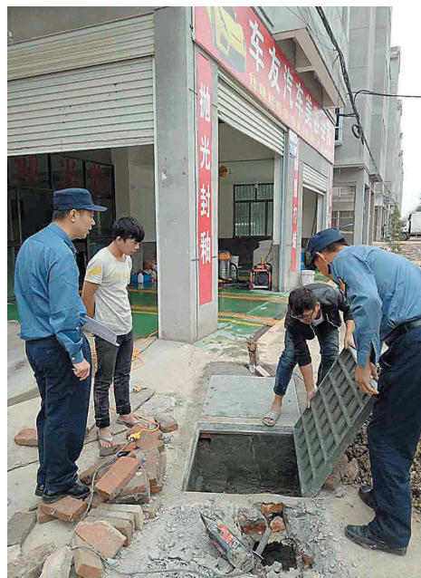
汽修洗车店沉淀池改造工作。
