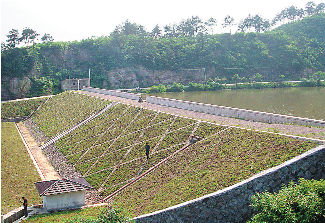
龙山镇后湖坑水库实行物业化管理后面貌焕然一新
