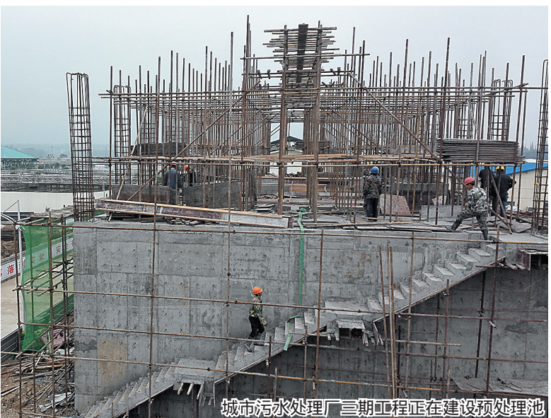
城市污水处理厂三期工程正在建设预处理池
