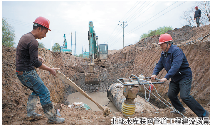
北部水库联网管道工程建设场景
