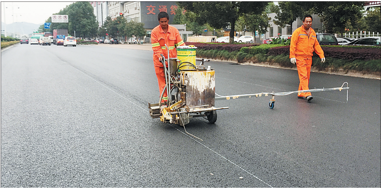
标线施工 13日 ,记者在330国道上看到 ,工作人员正在为道路标线。据了解 ,为进一步完善该路段公路安全设施 ,施工人员抢抓晴好天气 ,对重新罩面路段施划了标线和人行横道线 ,预计22日完成。 记者 杨成栋 摄
