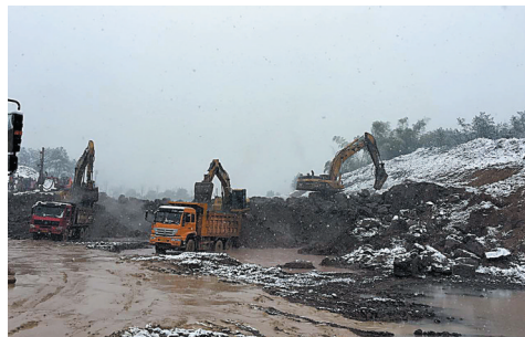
施工人员冒雪在丽州南路延伸段作业(资料图)
