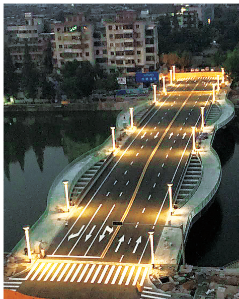
重建后的解放桥夜景
