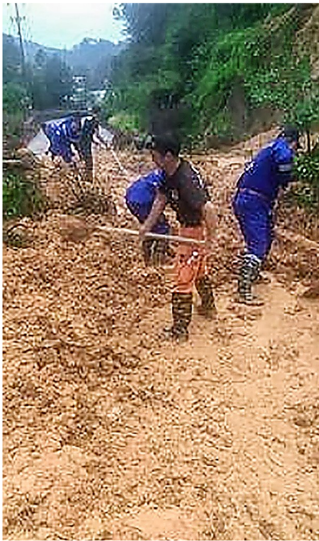
救援队员清理路障抢通道路
