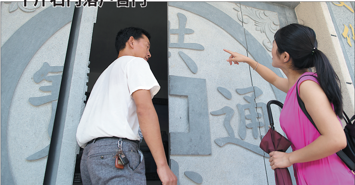
近日,舟山镇台门村文化礼堂的一扇大石门吸引不少参观者的眼球。据了解,这扇大石门由4部分构成,左右2扇固定,中间2扇可转动,每一扇门重量达到350公斤。
