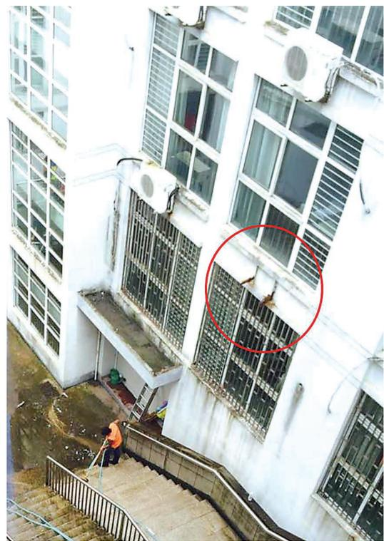
▲圆圈处为断裂的空调外机支架
