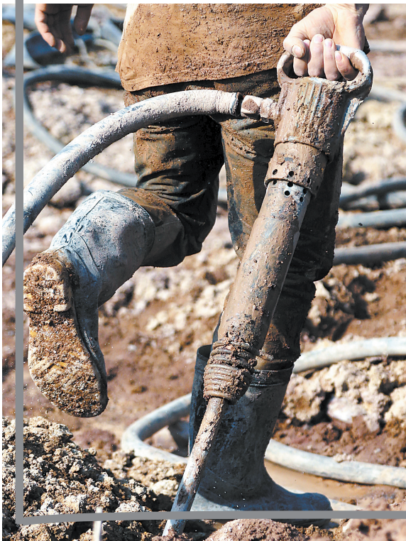
电镐是挖土的利器
