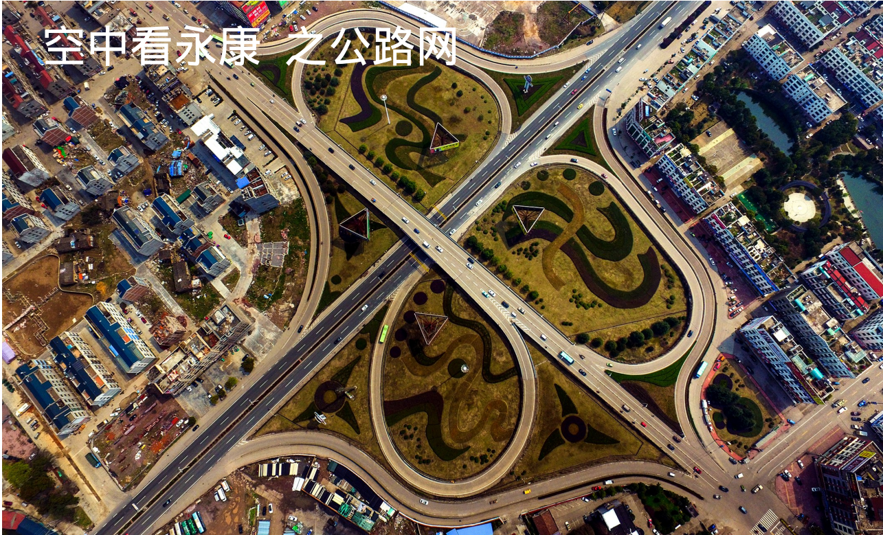
近年来,我市公路路网不断完善,从过去“树枝型”向“网络型”转变。十三五期间,我市将以“三高三环九射”公路为主框架,形成镇到高速、镇到城区半小时交通圈。图为花园立交桥。
