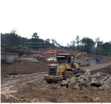
联建工程现场
