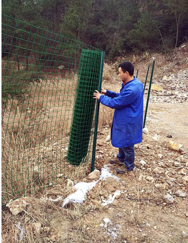
隔离网安装中
