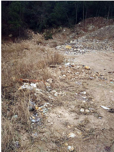
隔离网安装前
