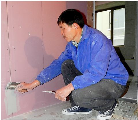
经过翻新,石膏板隔墙壁防潮功能增强。
